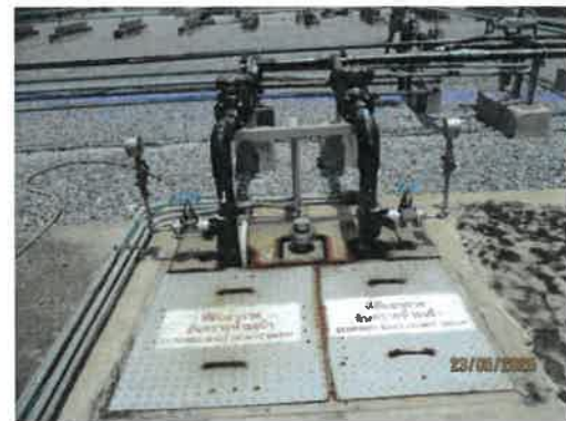
ภาพที่ 2.2-10 บ่อตรวจสอบคุณภาพน้ำทิ้ง พร้อมมวลถว ของโรงไฟฟ้า
