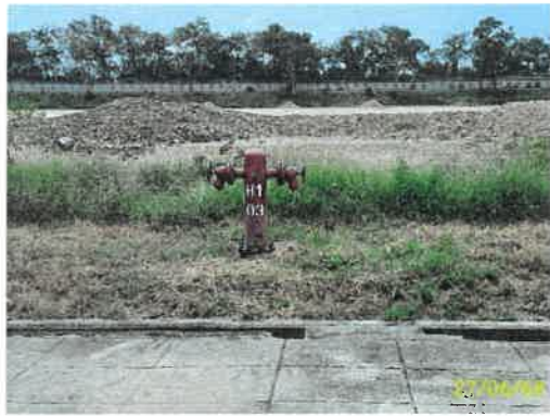
ภาพที่ 1.5.7-1 (ต่อ) หัวรับน้ำดับเพลิง
