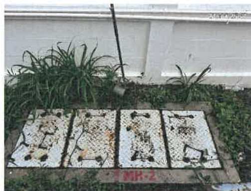
ภาพที่ 2.2-4 Inspection Manhole โรงงาน
